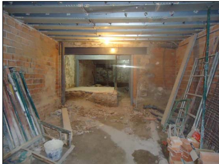
Vista inicial des del sud-oest de la zona a rebaixar.
